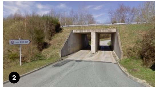
Accès VL depuis RN 145
